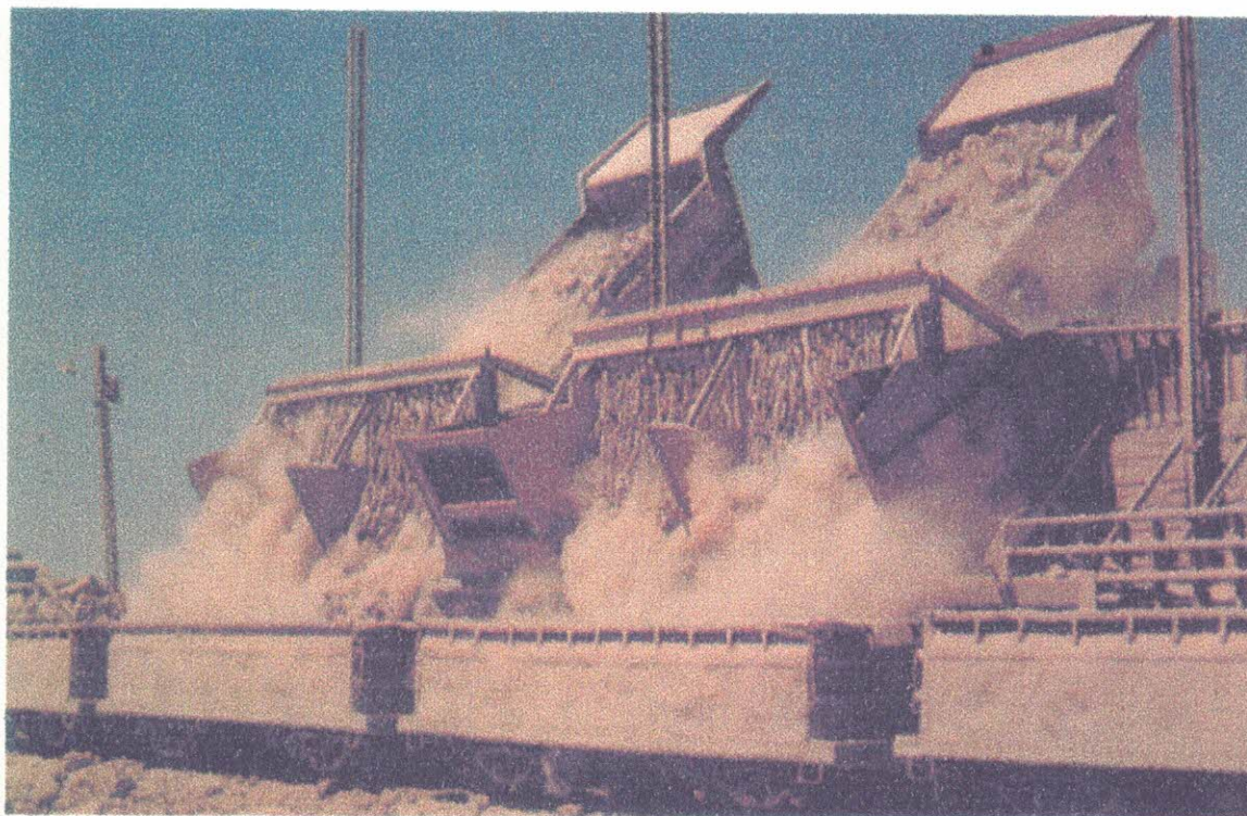
Sistema de carga del Caliche a carros de ferrocarril por rampa.
